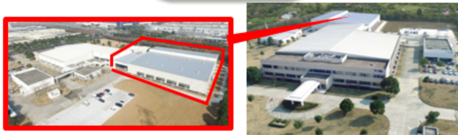
TOWA半導体設備（蘇州）有限公司
