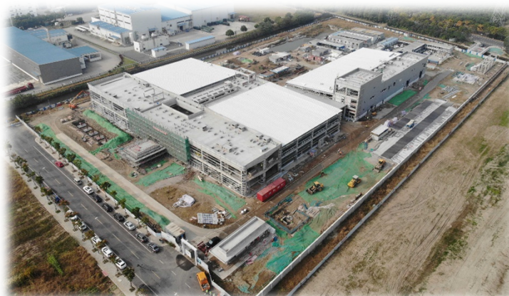
建設中の状況(2021年2月竣工予定)
