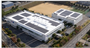
既存棟・新棟ともに設置完了 (京都東事業所)
