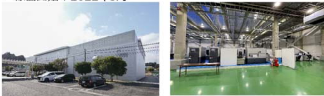
京都東事業所新棟の外観と工場内
