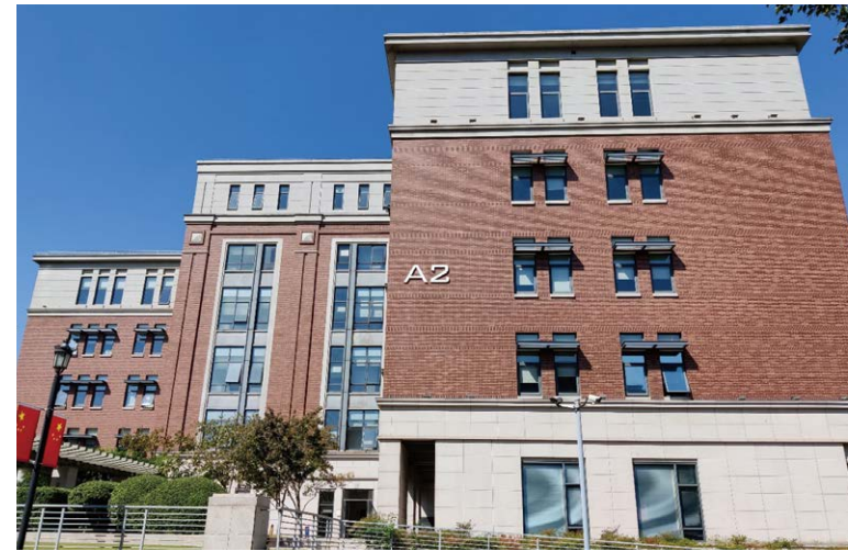
東和半導体設備研究開発(蘇州)有限公司が入っているビル
