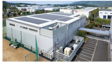
京都東事業所では新棟に太陽光パネルを設置
