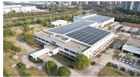
蘇州工場の太陽光パネル
