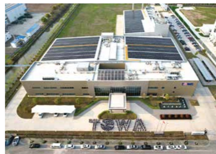
南通工場の太陽光パネル
