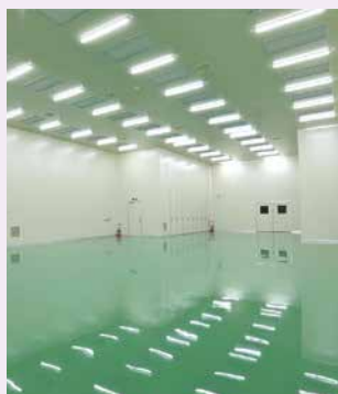
クリーンルーム
