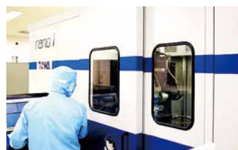
ナノレベルの加工を支える設備と環境も強みの一つ(超微細加工設備)
