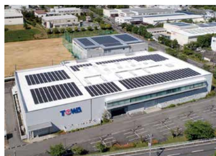
京都東事業所は既存棟 (手前側) にも太陽光パネルを設置
