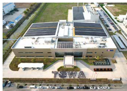
南通工場の太陽光パネル
